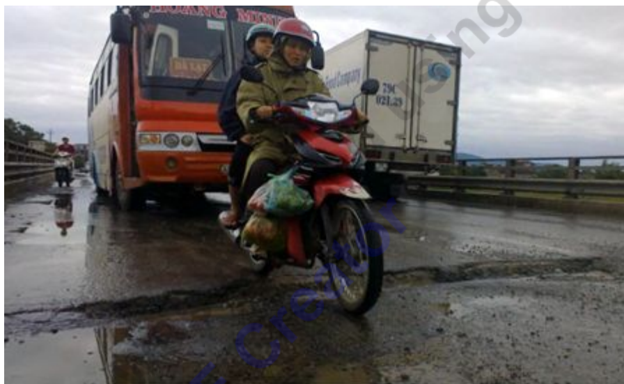
Những rãnh sâu trên mặt cầu khiến người không quen đường giật mình.
